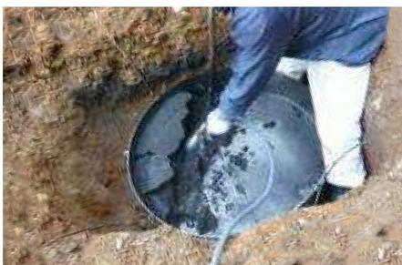
炭素粉を投入した後は、炭素層は周囲の土壌と一体化し強固にするため十分な散水による炭素粉の締め固めをします。十分な水の供給は、地中のイオンの流動性を増し、炭素埋設の効果を高めるためには必須です。締め固めを行う前の炭素層の深さは 50cm 以上にもなるため、お風呂に水を入れるくらいに大量の水が必要になります。炭素埋設孔の底までしっかりと水が染込み、炭素層の表面に水がたまるまでたっぷり
