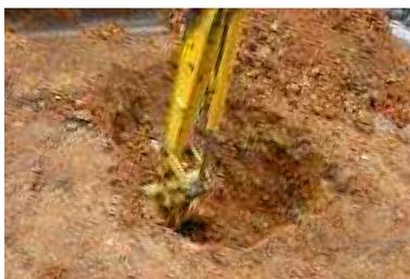
次に各炭素埋設箇所に炭素埋設孔を掘りますが、直径約 90cm、深さ約 90cm もの穴を掘る必要があります。労力のかからないユンボで行えば良いと思います。また、写真に写っています銀色の桶のようなものは、炭素埋設を手早くきれいにを行うために考えた専用金具です。
