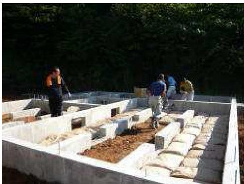
基礎コンクリート以外の床下の範囲に敷炭をします。敷炭する範囲に敷炭用粉炭を並べ、敷き詰めていきます。この時、敷炭の厚さは約5~10cmで調整します。
