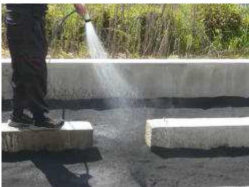
敷炭作業の仕上げは水撒きです。敷炭の炭は砂粒状の炭ですが、炭素埋設と同様、水で十分に締め固める作業が必要となります。このまま水撒きせずにおくと、建物が完成した後、しばらくの間は炭の吸湿効果により、室内がカラカラに乾いてしまいます。そこで敷炭を施した全面に大量に水撒きをして炭をしっかり和締め固めます。
